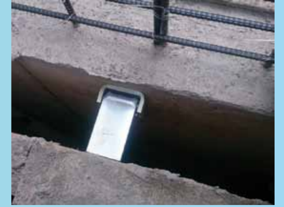
内型枠スライド前の 型枠支持ブラケット取付
