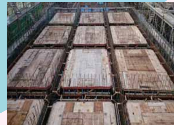
内型枠スライド完了
