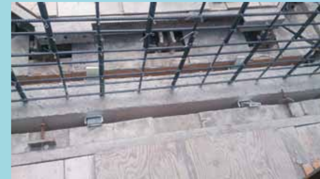
型枠支持ブラケット完了 (1面に2ヶ所)
