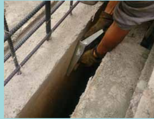
内型枠スライド前の 型枠支持ブラケット取付
